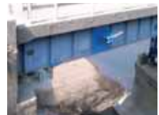
PCケーブルによる 変位制限装置
